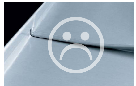
Pultdachfirst ohne Bewegungsbereich und zu geringer Aufstellhöhe
