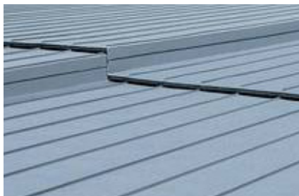
Quernaht als Gefällestufe
