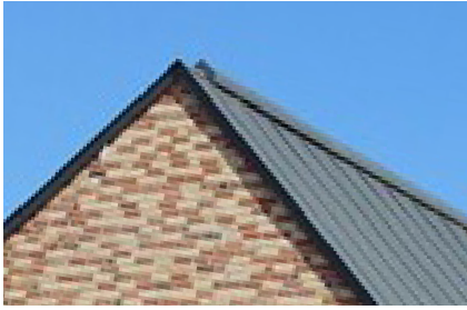
Satteldachfirst hohe Ausführung mit Entlüftungsquerschnitten
