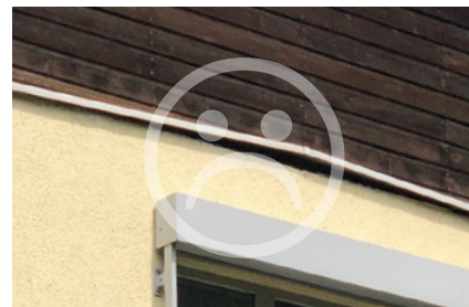
Aufwölben der Gesimsabdeckung durch fehlende Bewegungsausgleicher
