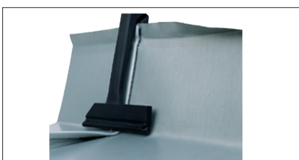
Aufstellen mit abgerundeter Quetschfalzzange
