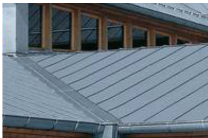
Kehle mit Einfachfalz und Zusatzhaftstreifen
