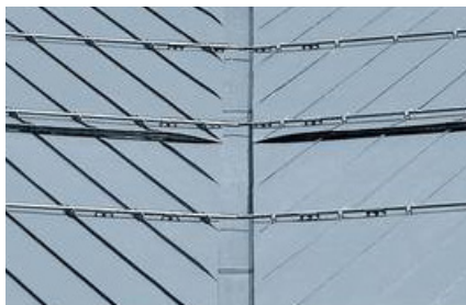
Kehlrinne vertieft auf Strukturmatte
