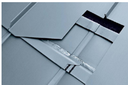
Detailoptimierung: Zusatzhaftstreifen
