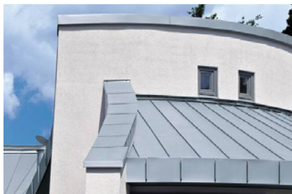
Verbindungstechniken und Ausbildung von Profilstößen
