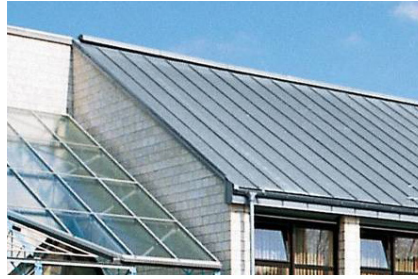
Pultdachfirst mit Holzleiste
