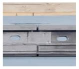
Die Längenausdehnung des Materials wird durch einen 3 mm breiten Spalt zwischen den Rinnenschienen ermöglicht.
