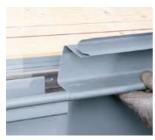
Zur einfacheren Montage wird ein Stück aus der Rinne ausgeklinkt. Die Rinne wird eingedreht...
