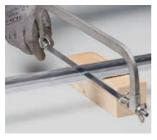
Die 3000 mm lange Rinne kann mit der Eisensäge, Kreissäge oder dem Winkelschleifer abgelängt werden.
