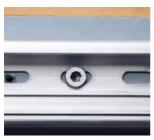
Die Schraubenköpfe sollten so tief versenkt werden, dass sie – z. B. bei einer möglichen Demontage der Rinne – so wenig wie möglich stören.
