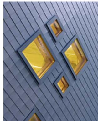
Die pyramidenförmigen Lichtkuppeln bestimmten die Größe und Anordnung der Dach- und Fassadenbekleidung.
