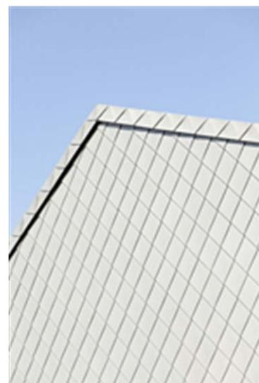
Exakte Vorarbeiten und die Vermessung der Fassade mit einem Laser bildeten die Grundlage für die Verlegung. Für die Fassaden und das Dach kam Titanzink als als Quadratraute zum Einsatz.
