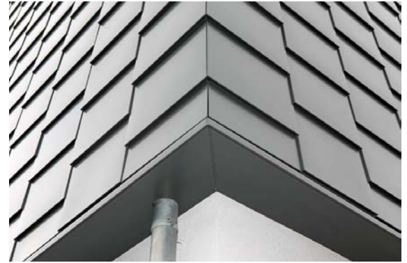
Der Blick auf die Ecke zeigt die handwerkliche Perfektion bis ins Detail, aber auch die identischen Strukturen in beiden Blickrichtungen, die durch die Hinterlegung der senkrechten Fugen mit Hutprofilen erreicht wurden.
