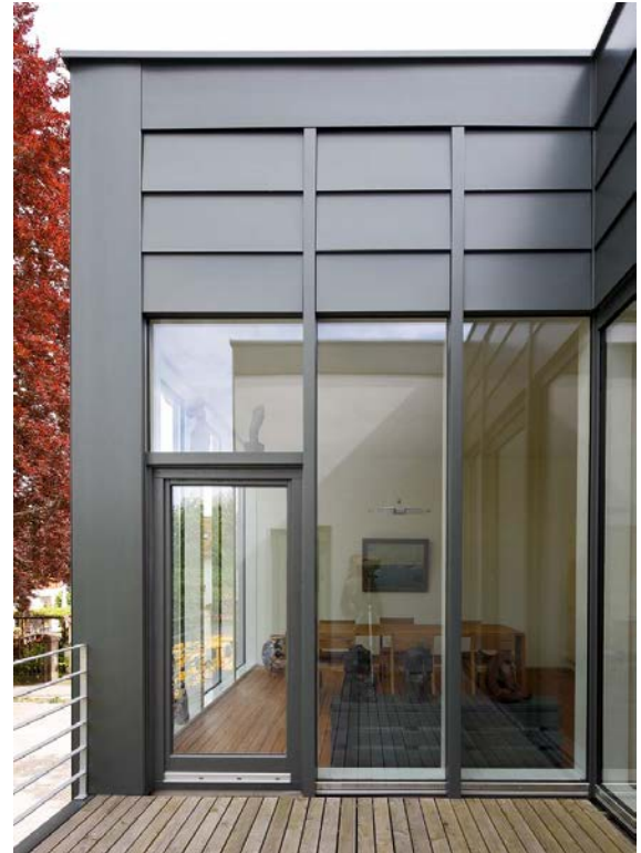
Die beiden abgeteilten Räume für Büro und Besprechung sind auch äußerlich durch ihre Verglasung und die hier verwendeten Stulppaneele aus Titanzink ablesbar.
