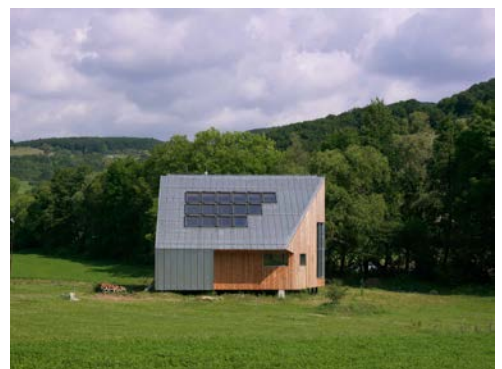
((Datei: 2316-041), Bild: RHEINZINK) Titanzink-Wrap: Das Gebäude wurde in Nord-Süd-Richtung mit Titanzink bekleidet.
