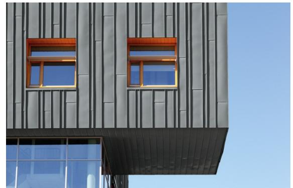
Auf der Unterseite kamen Steckfalzpaneele zum Einsatz, an den Fassaden die Winkelstehfalztechnik.
