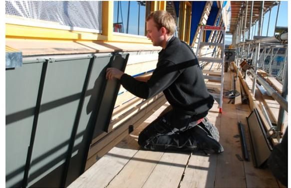
Die Verlegung erfolgte in Winkelstehfalztechnik im Wilden Verband auf vorgefertigten Holzrahmenelementen.
