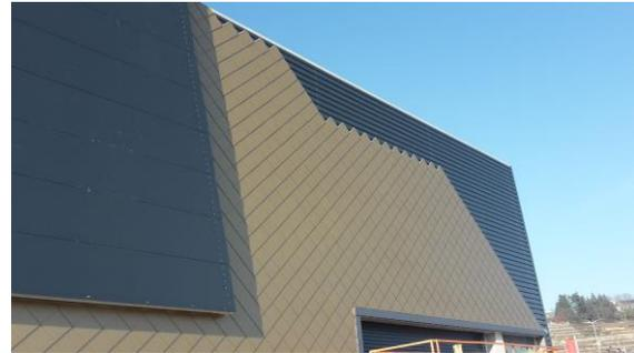
Rechts die quadratischen Multi-Form-Rauten während der von unten nach oben stattfindenden Montage auf dem Trapezblech. Die hier noch sichtbaren Isopaneele links wurden mit einer Fassade aus HPL-Platten bekleidet.
