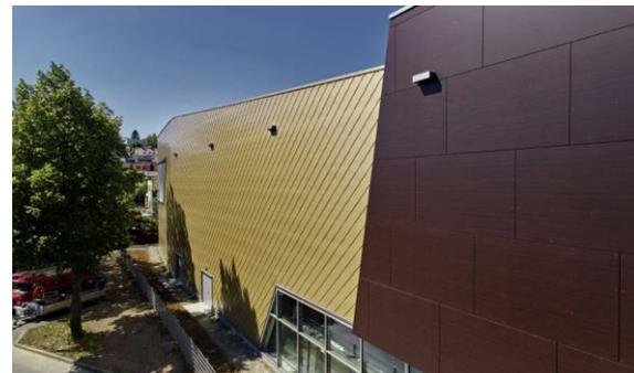
Die Titanzinkrauten bilden durch Spiegelung und Glanz einen spannenden Kontrast zur dunklen Fassade. Zu erkennen ist die leicht abknickende Linie der Wand, die sich durch die geometrische Anpassungsfähigkeit der Rautendeckung jedoch ästhetisch überzeugend beherrschen ließ.
