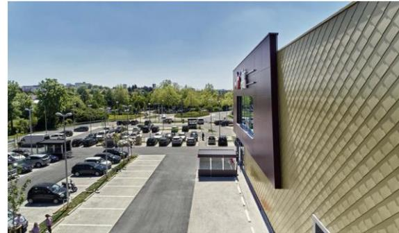
Im Unterschied zu Platten oder Schindeln weisen Rauten Vor- und Rückkantungen auf, mit denen sie ineinander gehängt und dann befestigt werden. Es entsteht eine betont plastische Fassade, die mit der Sonneneinstrahlung lebendige Schattenspiele erzeugt.
