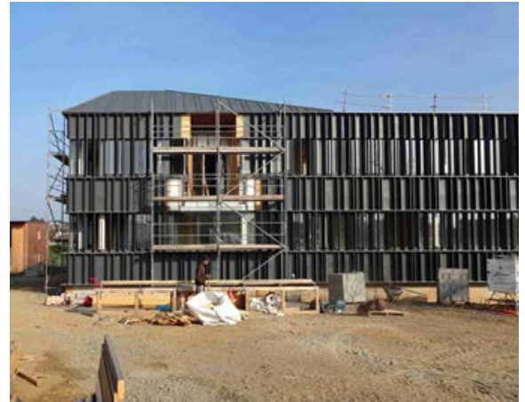
((Datei: (c)a+samueldelmas_Pose brise soleil)) Die Fassade ist als vorgehängte hinterlüftete Fassade ausgeführt. Foto: a+ samueldelmas_Pose
