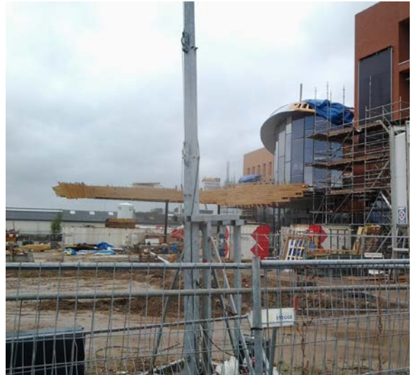
((Datei: 2012-10-05 12.36.32)) Die Umhüllung wurde als Kalt- und als Warmdachkonstruktion ausgeführt. Foto: Elshof Metaaldak
