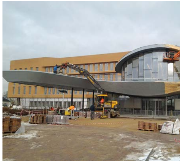
((Datei: 2012-12-14 10.10.33)) Für die Formgebung wurden Doppel-T-Träger mit Leimholzbindern kombiniert. Foto: Elshof Metaaldak
