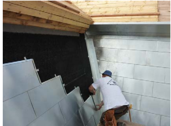
((Datei: gbelany-kastiel-mh-214054-008)) Die Großrauten wurden in einer Materialdicke von 0,7 mm, einer Baubreite von 330 mm und einer Baulänge von 630 mm verarbeitet und jeweils mit drei Einzelhaften befestigt. Foto: Kontrakting stavebné montáže/Pluta – Strechy
