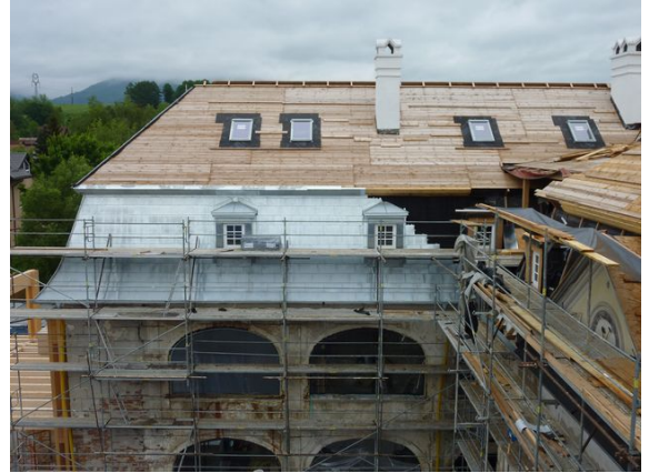
((Datei: gbelany-kastiel-mh-214054-019)) Der Dachaufbau (von innen nach außen): Holzschalung (32 mm), strukturierte Trennlage (RHEINZINK Vapozinc) und Deckung mit RHEINZINK Großrauten. Foto: Kontrakting stavebné montáže/Pluta – Strechy
