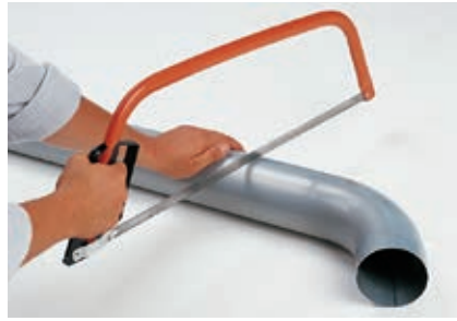
Einfaches Ablängen des RHEINZINK-Bogenrohrs
