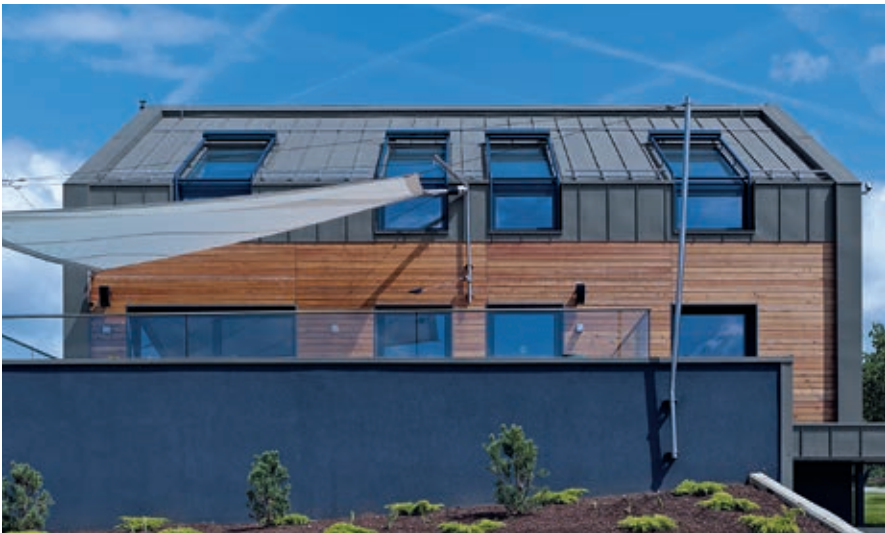
Stehfalzdeckung Dach/Fassade und Giebelabdeckung
