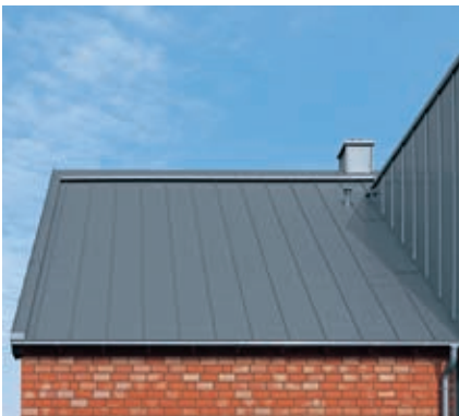
Stehfalzdeckung mit schmaler Giebelabdeckung und Lüfterfirst
