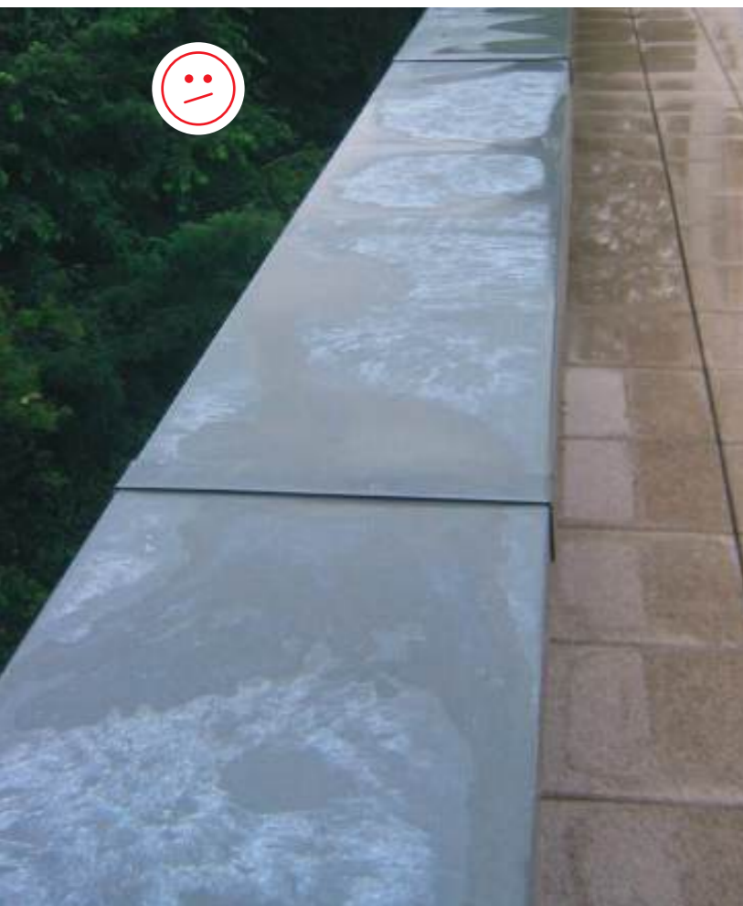
Bildung von Zinkhydroxid durch unzureichendes Gefälle
