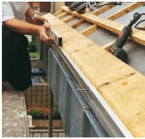
Überprüfung der Unterkonstruktion auf Fluchtgenauigkeit und Lot
