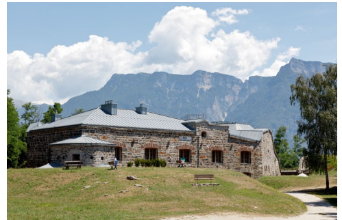
Der Bau setzt sich aus zwei Gebäudeteilen zusammen, die Kasematten für die Unterbringung der Truppen auf der einen Seite, die Panzerkasematten für die Kanonen auf der anderen Seite. Foto: Rheinzink
