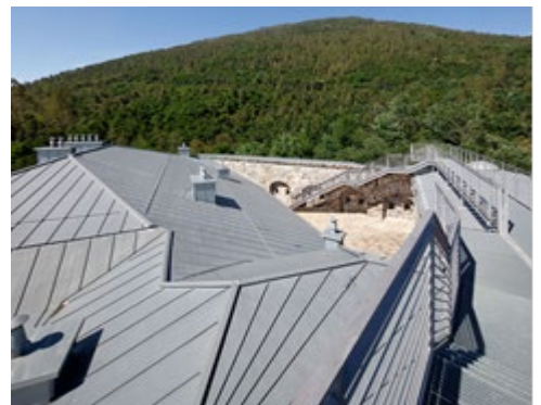
Eine besondere Herausforderung war die Komplexität der unterschiedlichen Dachneigungen. Foto: Rheinzink
