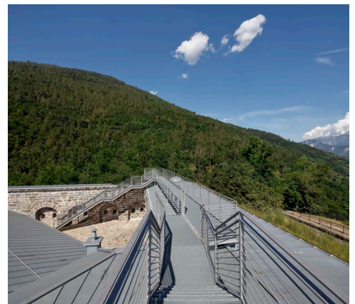
Die 1.000 m 2 große Dachfläche wurde im RHEINZINK-Doppelstehfalzsystem ausgeführt. Foto: Rheinzink
