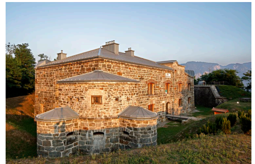
Die geschichtsträchtige Festung wurde zwischen 1883 und 1900 als Kasemattenbau errichtet. Foto: Rheinzink
