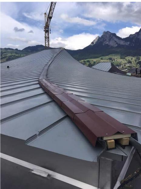
Einhängestreifen aus verzinkten und lackierten Stahlblechen bilden die Unterkonstruktion für die markanten Grathauben.
