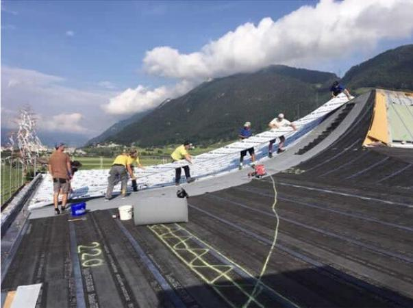
Das Dach wurde ohne Querstöße gedeckt, wodurch sich maximale Scharlängen von über 22 m ergaben. Sorgfältig geplante Langschiebehaften und der großzügige Freiraum zu den Rinnen ermöglichen eine unproblematische Längenänderung unter Temperatureinfluss.
