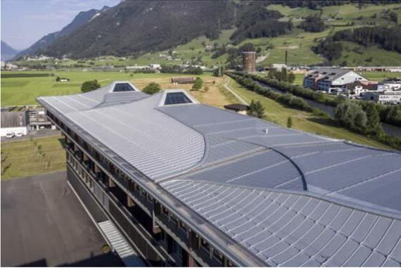
In der Primärstruktur der markant geschwungenen Dachflächen bilden die Grate, Doppelstehfalze und Schneefänge ein feines sekundäres Linienmuster. Die großen Räume unter den drei Dachspitzen werden über die jeweils eingebauten Fenster mit Tageslicht versorgt.
