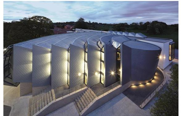
Die Pultdächer des sägezahnartigen Daches mit Doppelstehfalzeindeckung
