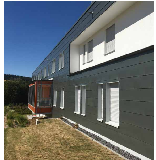
Das Verlegebild erinnert an Schindeln, tatsächlich handelt es sich jedoch um RHEINZINK-Großrauten, die mit Vor- und Rückkantungen ineinander eingehängt werden. Foto: RHEINZINK
