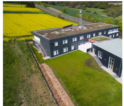
Mit der neuen Dachdecker-Herberge für Azubis während der überbetrieblichen Ausbildung hat das Bundesbildungszentrum des Deutschen Dachdeckerhandwerks (BBZ) in die Zukunft investiert. Foto: BBZ
