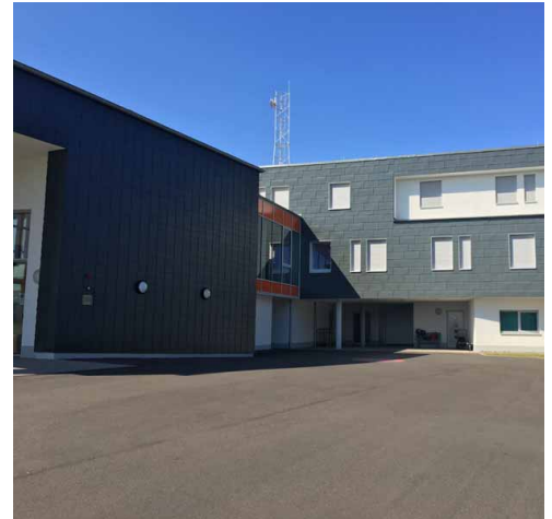
Die Großrauten mit ihren horizontalen Reihen fügen sich harmonisch in die betont rechteckige Formensprache des Entwurfs ein. Foto: RHEINZINK
