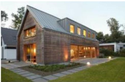
Das Dach wurde auf einer Fläche von 180 m<sup>2</sup> mit RHEINZINK-prePATINA blaugrau im Winkelstehfalzsystem verkleidet, die Holzfassade besteht aus Douglasie.
