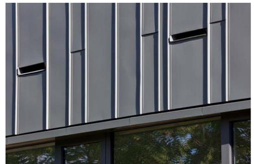
Das Detail am Sturz zeigt die bis zur Falzoberkante reichenden Fenstereinfassungen, hinter denen sich – gegen Brandeintritt geschützt – die Zuluftöffnungen befinden. Über dem Fenster sind die Notentwässerungen für den Hof im ersten Obergeschoss zu erkennen, deren Größe und Lage ebenfalls auf den Fassadenrhythmus abgestimmt ist.
