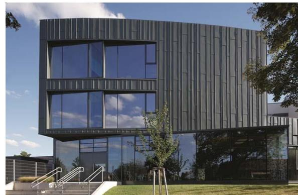
Die Fenster folgen mit ihrer versetzten Anordnung der gekrümmten Baufluchtlinie. Ihre ebene Oberfläche betont die leichte Rundung der Fassade.
