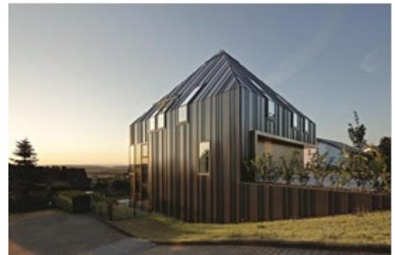
Die homogene Bekleidung von Dach und Fassade mit schiefergrauem Titanzink in Winkelstehfalztechnik wirkt wie ein großer Faltenwurf über dem betont monolithischen und in sich geschlossenen Baukörper.
