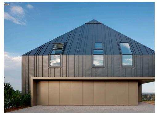
Die Eingangssituation mit dem Garagentor ist mit bronzefarbenem Aluminium vom schiefergrauen Titanzink abgesetzt und wirkt durch den Rücksprung wie aus dem Volumen herausgefräst.
