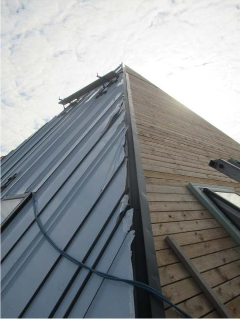
Die versenkt eingebaute Rinnenentwässerung erlaubte eine Ausführung mit offenem Grat und ohne den an dieser Stelle sonst notwendigen Falz.
