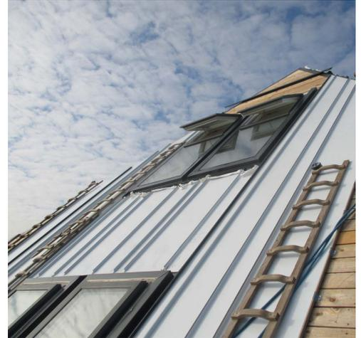
Wo es die Fensteranordnung erlaubte, wurde sowohl auf dem Dach als auch an der Fassade mit durchgehenden Scharen ohne Querteilung gearbeitet. Das schiefergraue Titanzink ist hier noch mit einer Folie geschützt.
