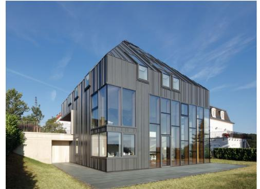
Auf der zum Garten weisenden Talseite befindet sich der über beide Vollgeschosse reichende Wohnbereich. Neun Achsen teilen die Pfosten-Riegel-Fassade in zehn Abschnitte gleicher Breite.
