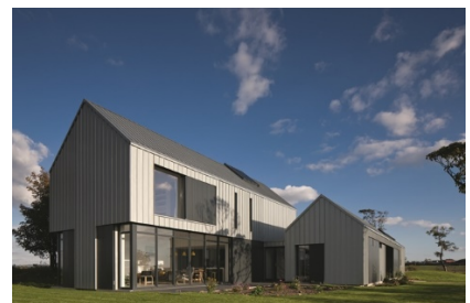
Die Dach- und Fassadengestaltung mit Titanzink unterstreicht das Konzept des landwirtschaftlichen Anwesens.
