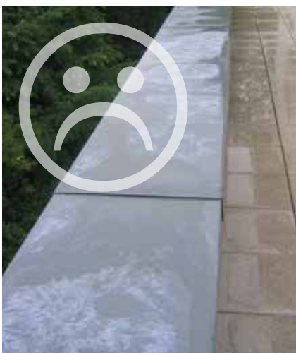
Bildung von Zinkhydroxid durch unzureichendes Gefälle
